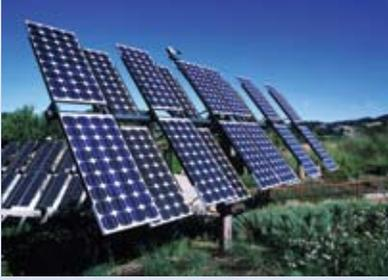
الخلايا الكهروضوئية المصنوعة من مادة السيليسيوم يتم تعريضها للضوء لتتحرر الالكترونات ومن ثم يتولد التيار الكهربائي .
