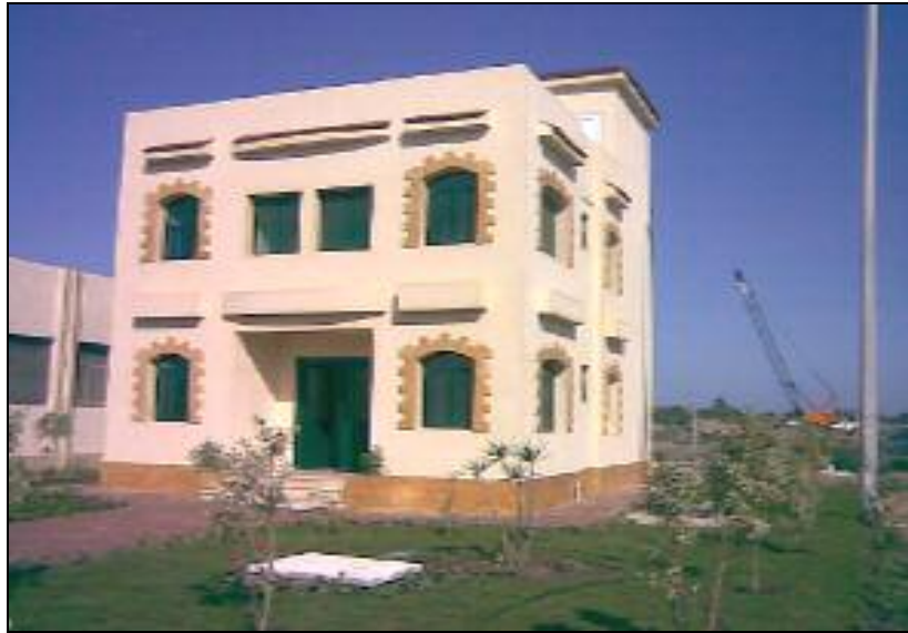
( شكل ٥ : يبين المرصد البيئي التابع لوزارة الدولة لشئون البيئة داخل هيئة ميناء دمياط )
