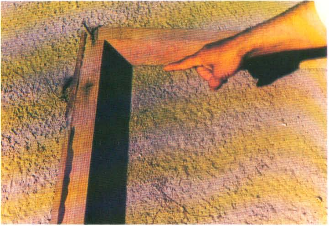
صورة رقم (٣) طريقة تثبيت المسامير في خشب القاعدة
