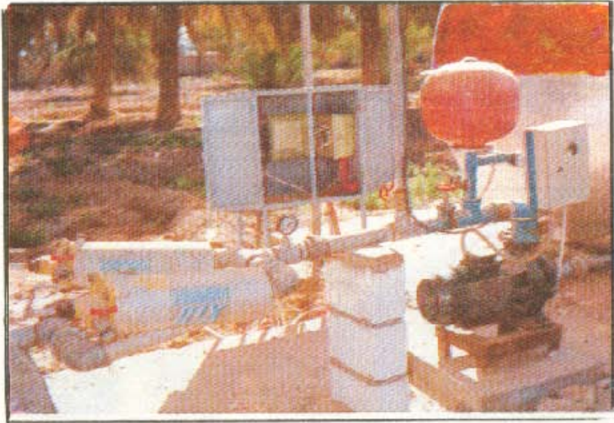
صورة توضح جهاز الري الآونوماتيكي .
