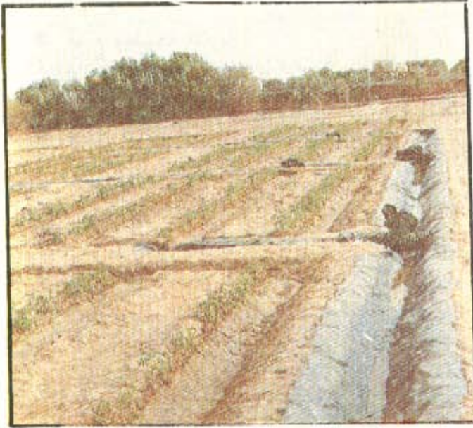
فقد مياه الري بالرشح والبخر من قنوات الري المفتوحة.
