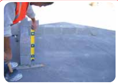
الشكل (٣٠) ضبط شاقولية الجدار .
