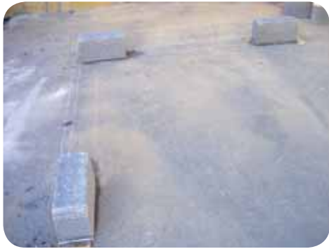
الشكل (٣٦) تثبيت طوب الزاوايا
