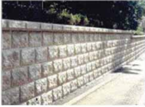
الشكل (٤١) من اشكال البناء بالطوب الرملي الجيري
