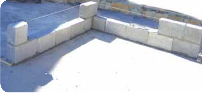
الشكل (٣٧) تثبيت طوب زوايا المدماك الثاني
