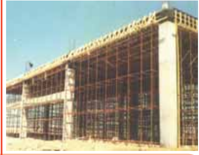
طوبار باستخدام الخشب ومواسير وجكات على شكل شبكي للأسقف العالية.
