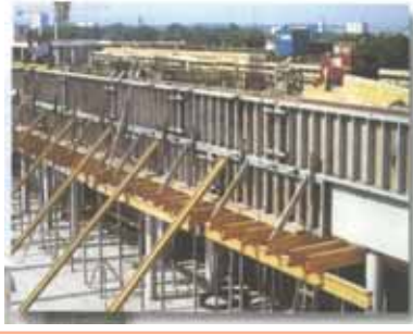
طوبار باستخدام ألواح معدنية لطوبار الحوائط
