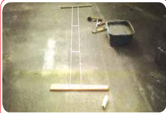
الشكل (٢٦) قطع خشبية لتحديد مواقع الجدران
