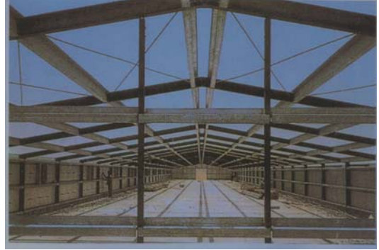
شكل (4) المباني سابقة التجهيز (الهيكل المعدني ثم المواد العازلة للحرارة)
