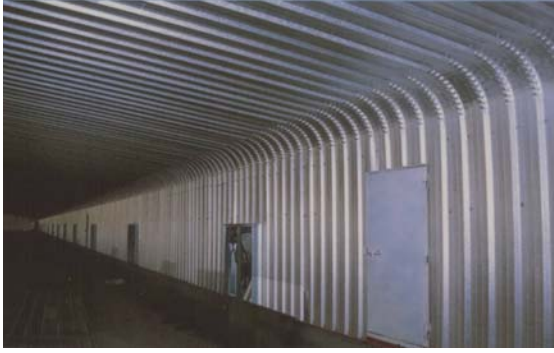
شكل (4) المباني سابقة التجهيز (الهيكل المعدني ثم المواد العازلة للحرارة)
